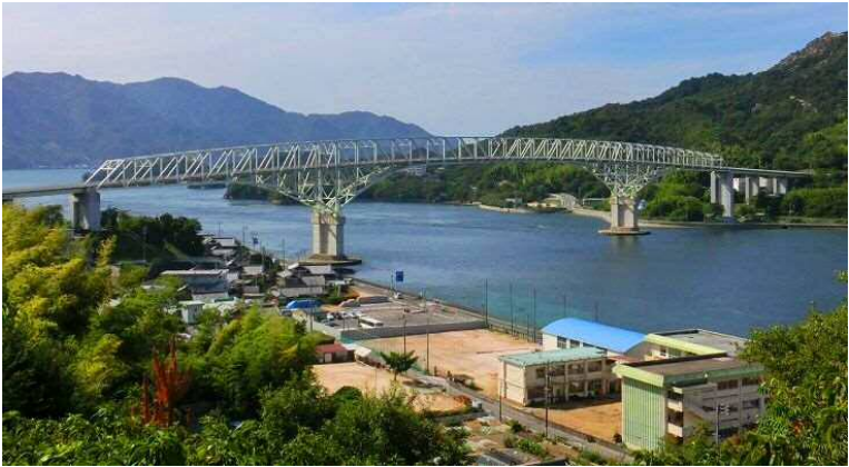
一般国道487号 早瀬大橋
