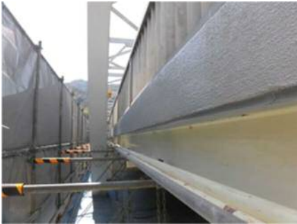
橋梁補修完了区間（床版・地覆）
