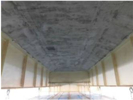
橋梁補修完了区間（床版・地覆）
