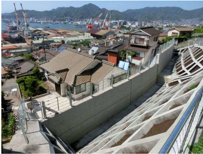
急傾斜地崩壊対策事業 宮原八丁目
