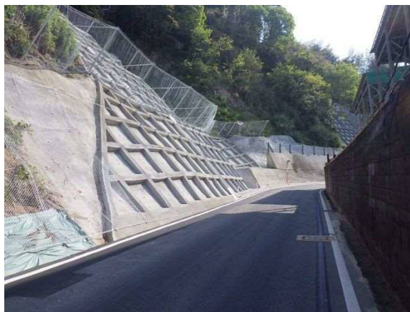
主要地方道呉環状線 呉市警固屋
