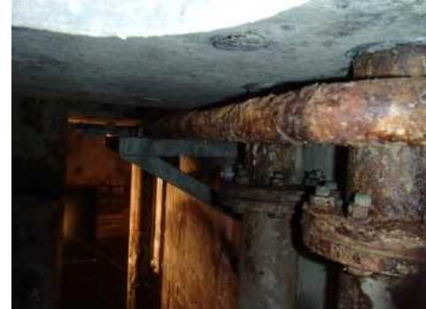
処理場内配管 腐食状況
