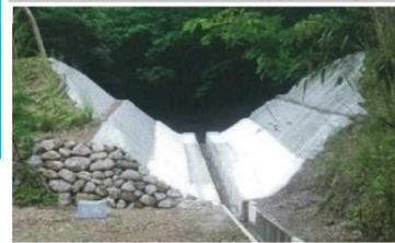
《利用しなくなったため池の廃止工事》
