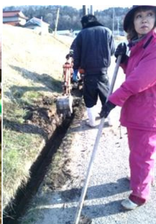
水路清掃の様子
