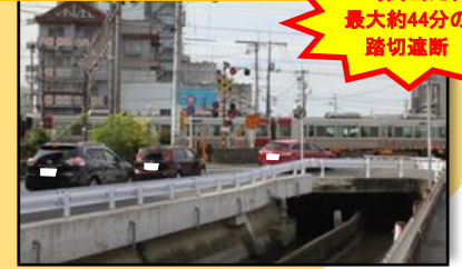
新町踏切(海田町) (開かずの踏切)
