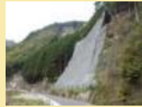
法面災害防除工事例 (落石防止)
