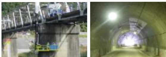
橋梁の点検状況
