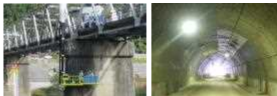
橋梁の点検状況
