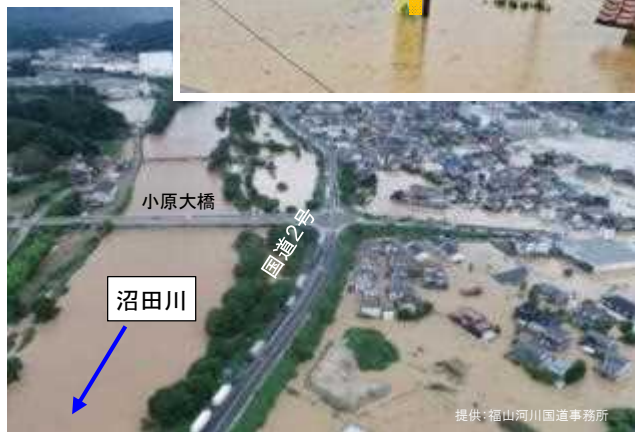
三原市本郷町の浸水状況
