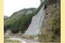
法面災害防除工事例 (落石防止)
