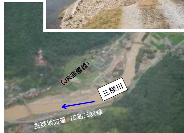
広島市安佐北区の浸水状況
