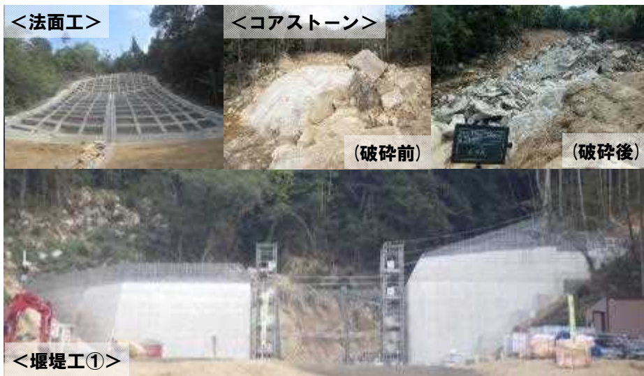
災関緊急の実施状況（安芸郡熊野町川角）
