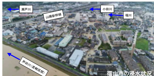
福山市の浸水状況
