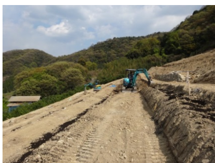
園地整備による植栽の機械化作業 (平成25年3月)
