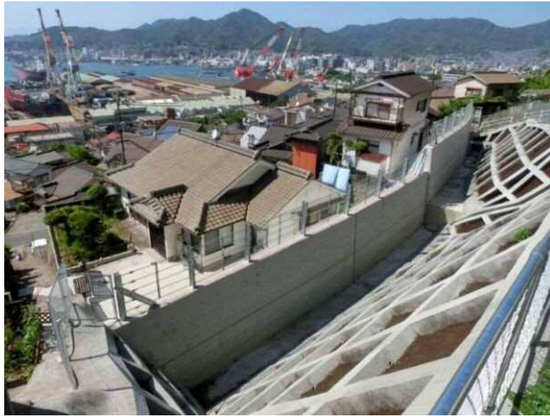
急傾斜地崩壊対策事業 宮原八丁目
