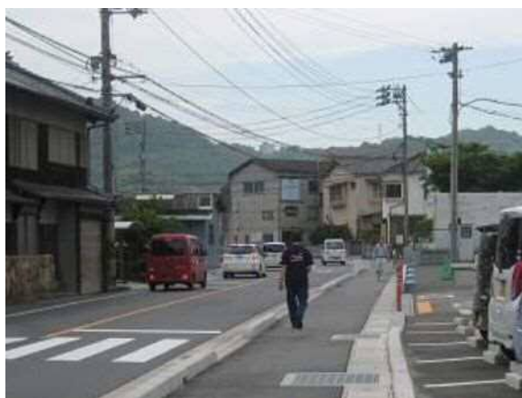
一般国道487号歩道整備 音戸町高須
