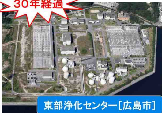
東部浄化センター[広島市] 昭和63年供用 (処理人口31万人)
