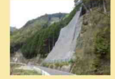
法面災害防除工事例 (落石防止)
