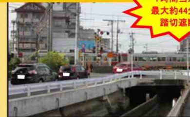
新町踏切(海田町) (開かずの踏切)
