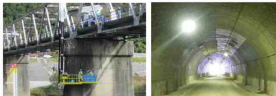
橋梁の点検状況
