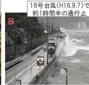
18号台風(H16.9.7)で約1時間半の通行止 国道2号の波浪・越波状況
