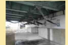
橋梁耐震工事例 (落橋防止)
