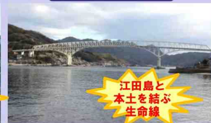
(国)487号 早瀬大橋(呉市~江田島市)
