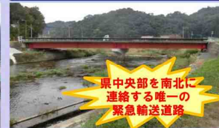
(国)375号 新大渡橋(東広島市)
