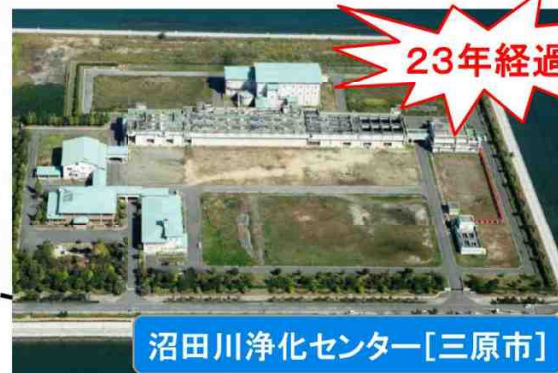
沼田川浄化センター[三原市] 平成8年供用(処理人口5万人)
