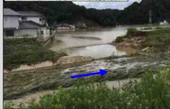
菅川(沼田川支川)の破堤状況
