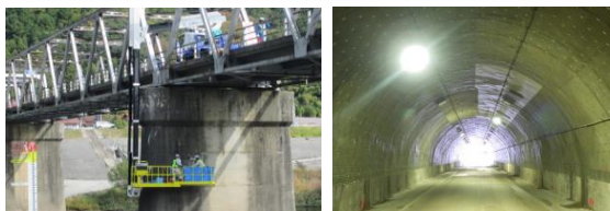
橋梁の点検状況
