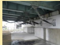
橋梁耐震工事例 (落橋防止)
