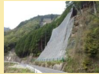
法面災害防除工事例 (落石防止)
