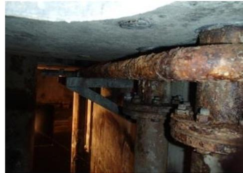
処理場内配管 腐食状況
