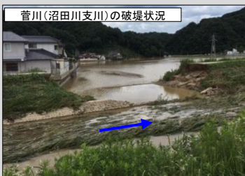
菅川(沼田川支川)の破堤状況
