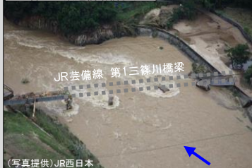
三篠川の鉄道橋落橋状況
