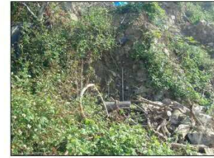
⑤ 崩壊状況
