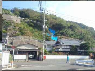
② 崩壊状況
