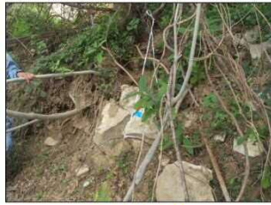
⑥ 崩壊状況
