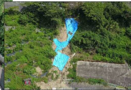
① 崩壊状況
