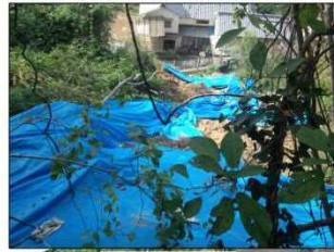
⑦ 崩壊状況
