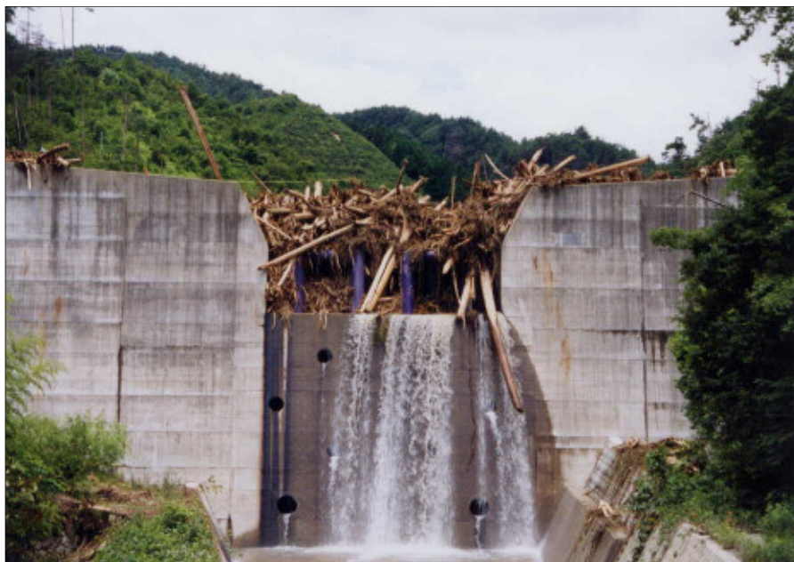
砂防堰堤工の事例
