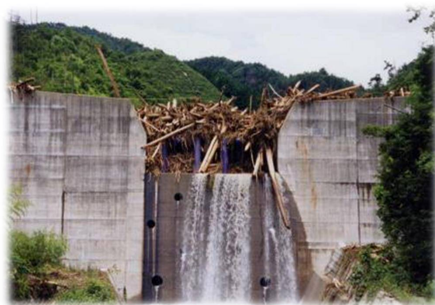
砂防堰堤工の事例
