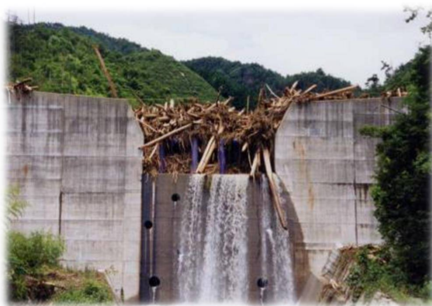
砂防堰堤工の事例
