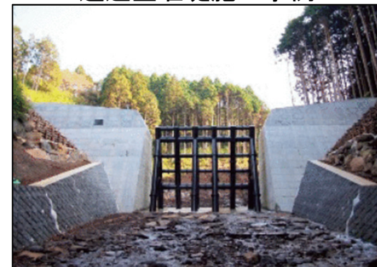
透過型堰堤施工事例
