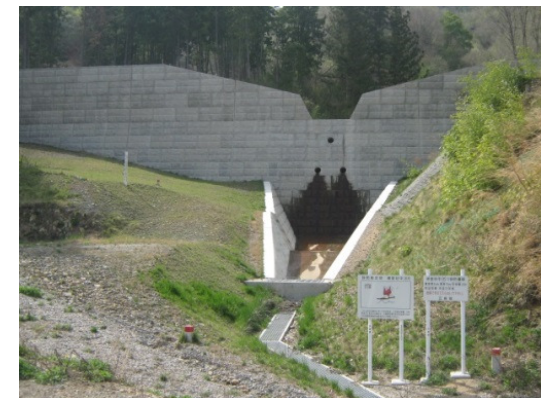
不透過型堰堤施工事例
