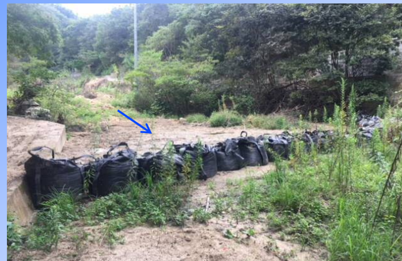
応急対策工：大型土のう
