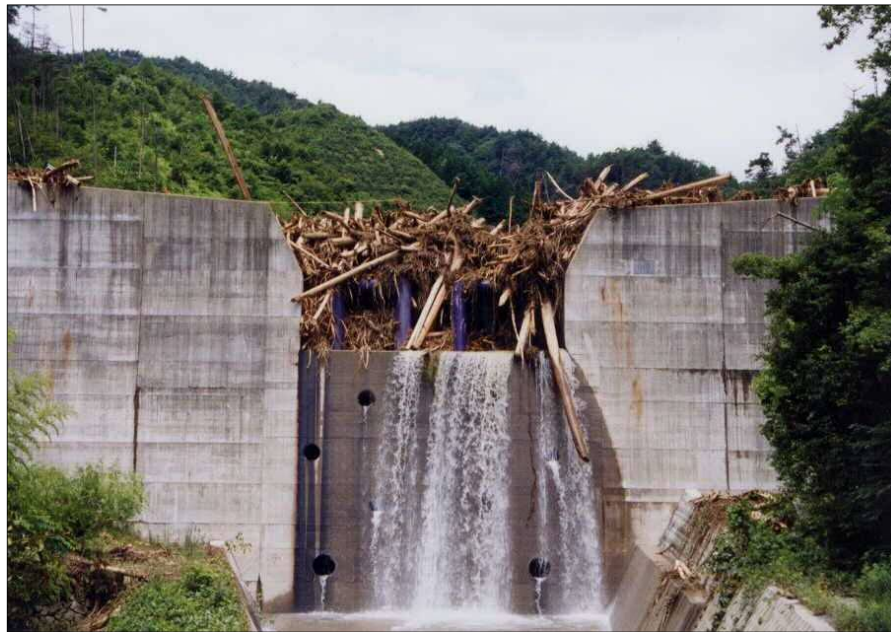
砂防堰堤工の事例
