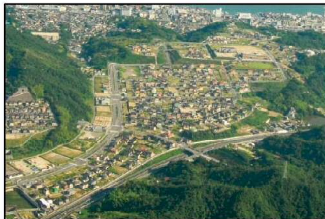
区画整理により整備された住宅団地 (平原台)
