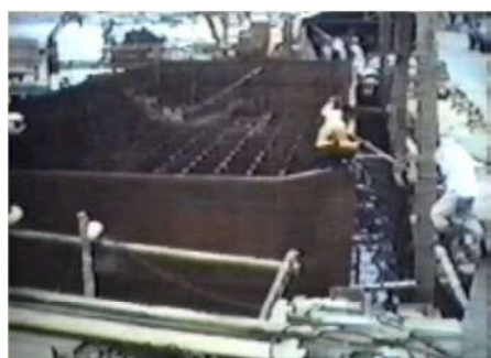
ケーソン据付け
