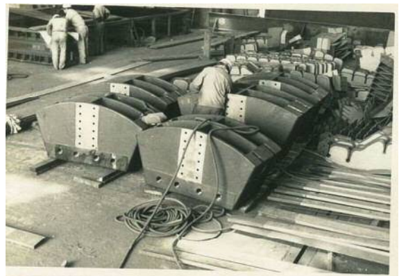
塔頂金物完成品(昭和42年3月)
