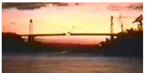
最終主桁の締結(昭和42年11月13日未明) (日本道路公団尾道大橋記録映画 (山陽映画(現RSKプロビジョン))より)
