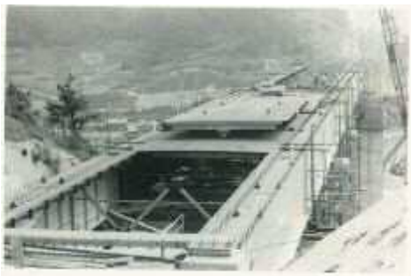
向島側の桁架設状況 (ステージング)
