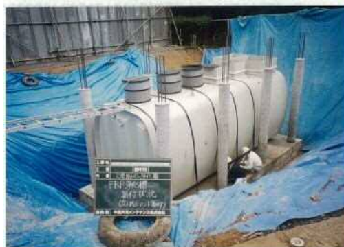
平成15年 公衆用トイレ浄化槽改修工事 (広島県道路公社)
