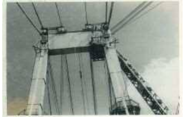
中央径間の桁架設状況
