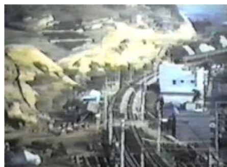
尾道側取付道路
