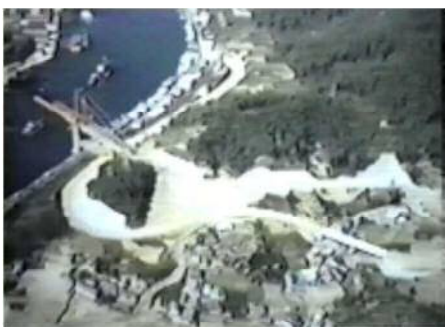
尾道側取付道路
