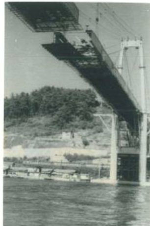
中央径間の桁架設状況
