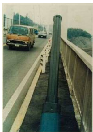
昭和60年 ケーブル防護カバー取替工事 (日本道路公団)
