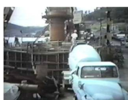
底打ちコンクリート打設
