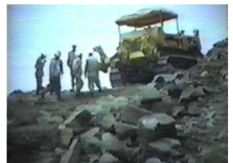
硬岩の掘削難航
