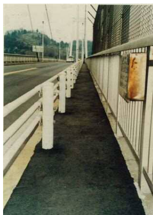
昭和60年 歩道舗装工事 (日本道路公団)
