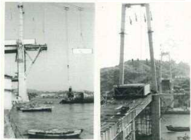
尾道側の桁架設状況 (エレクションガーダーによる送出)
