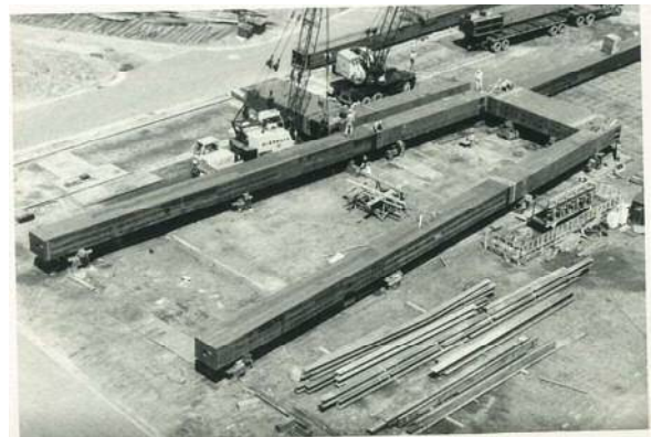
主塔仮組立(昭和42年4月)
