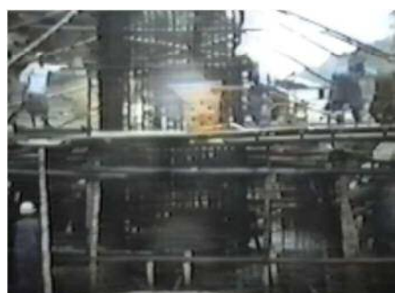
P2脚柱コンクリート打設
