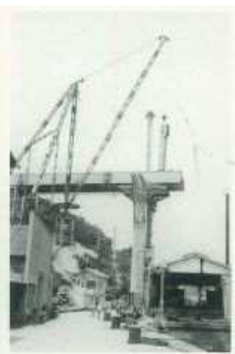
向島側の桁架設状況 (ステージング)
