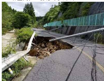
国道432号(三原市大和町)
