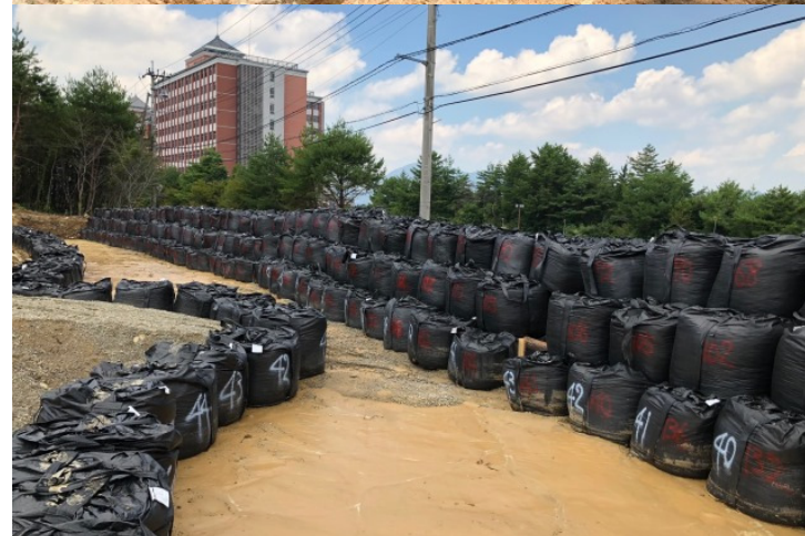
山腹崩壊発生箇所の下部に、応急対策として大型土嚢を設置 (東広島市黒瀬町)
