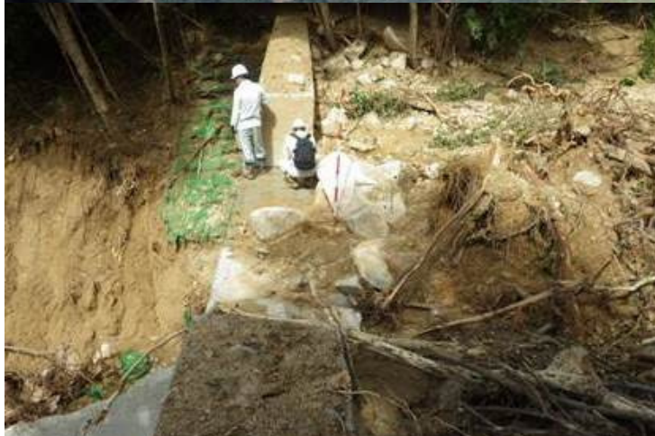
既設治山ダムの緊急点検 (8月～)
