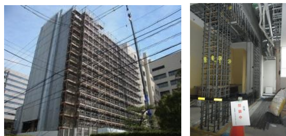
外壁工事に用足場の組立工事（左）や、部屋の間に新たな壁を増設する工事（右）など、大規模な耐震工事となっています。
