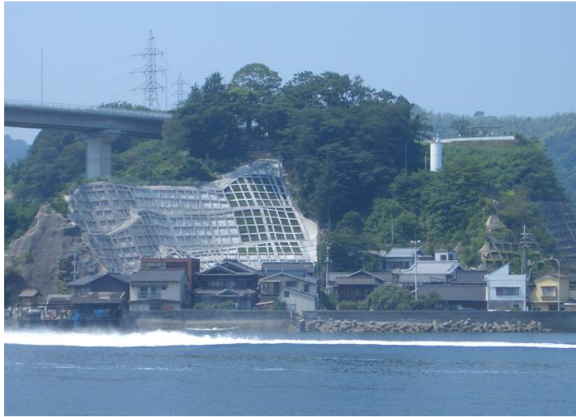
急傾斜地崩壊対策事業 音戸町坪井
