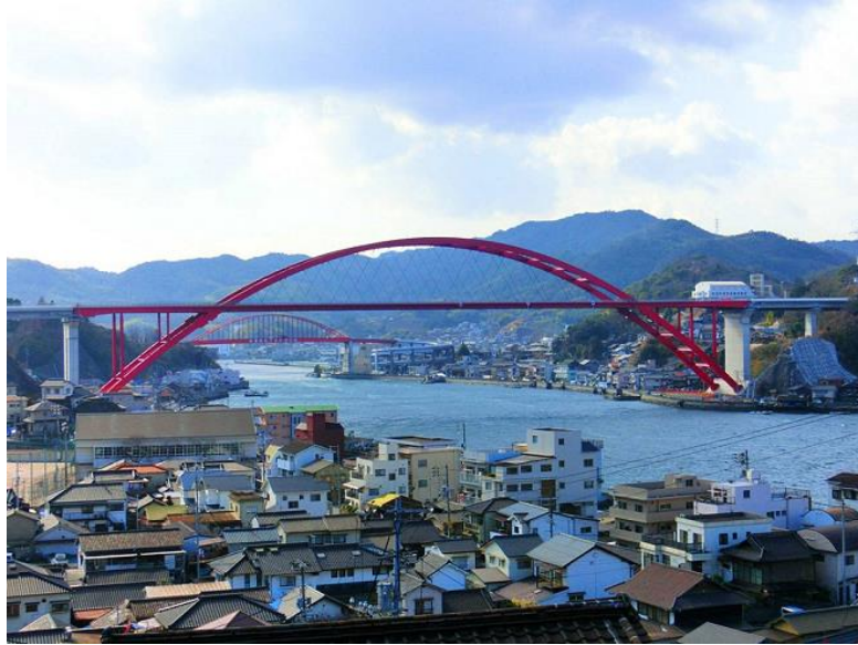
第2音戸大橋 完成写真
