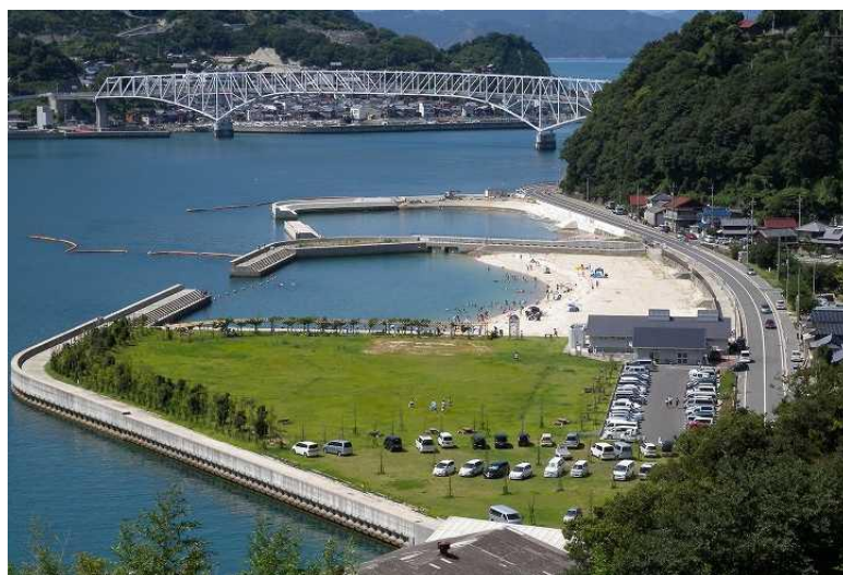
漁港環境整備・海岸環境整備事業 豊島漁港 大浜地区 (H22 完成)
