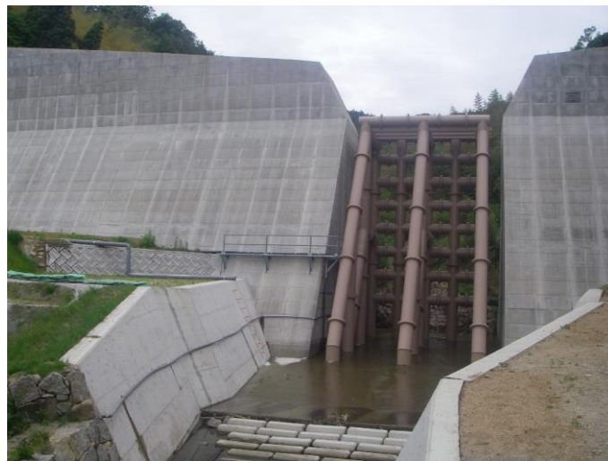
通常砂防事業 砂防指定地内河川 鈍田川
