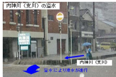
浸水被害の状況 (平成22年7月14日)
