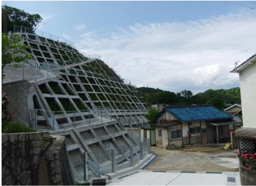
急傾斜地崩壊対策事業 音戸町南隠渡
