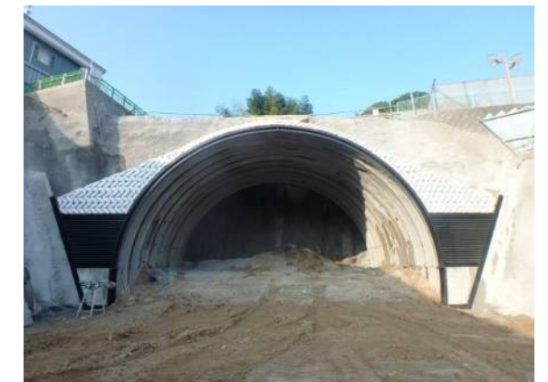
【終点側坑口全景】
