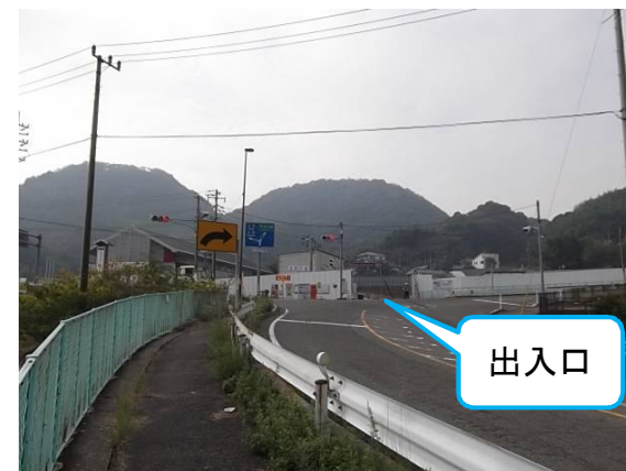
【現場出入口全景】
