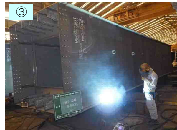
箱の形に組み立てた後、溶接にて鉄板とおしをつなぎ合わせ、箱のブロックを造ります。
