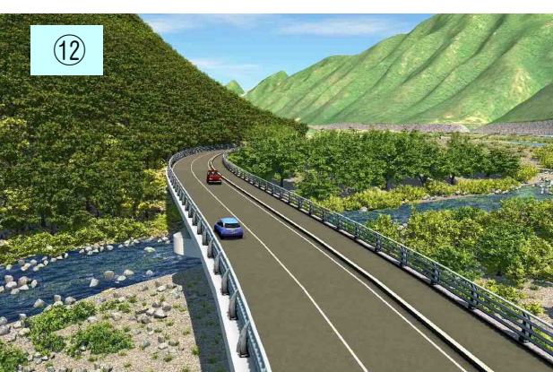
床が完成後、道路として使うことができるように舗装や手すりを設置して完成です。
