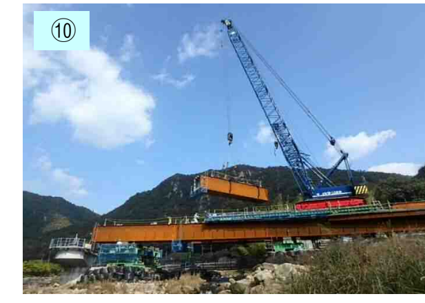
川の流れがある部分については、流れをせき止めることがないよう大型のクレーンを橋の上へのせ、移動させながら、橋をかけていきます。
