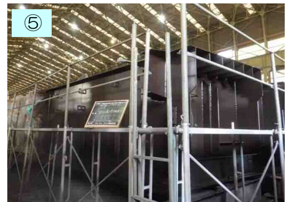
鉄板がさびないように塗装します。なお、下畑駒原橋はさびの進行を遅らせることができる特殊な鉄板を使用しているため、おもに箱の中を塗装しています。
