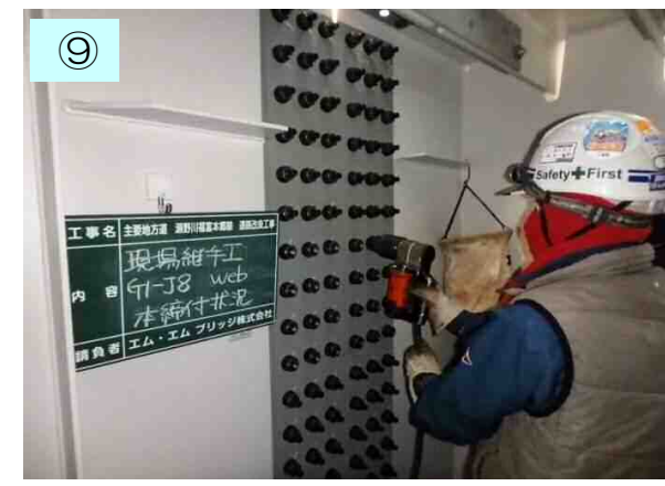
ブロックとおしはボルトでつなぎます。このボルトは強力なボルトで1本あたり10トンの力に耐えることができます。
