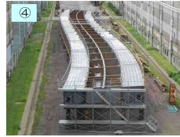
箱のブロックを工場にてつなげ、現地にてきちんと橋が組み立てられることを確認します。
