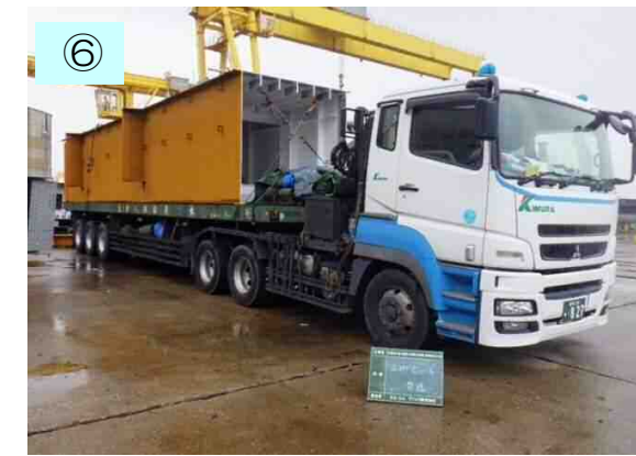
塗装後、箱のブロックをトレーラーにて現地まで運びます。
