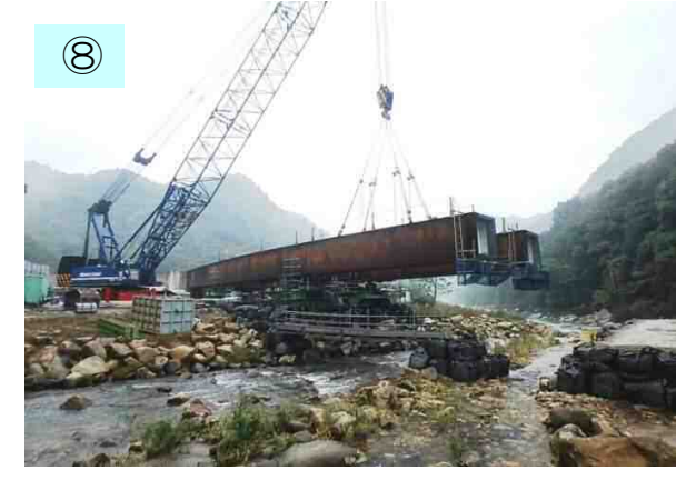
大型のクレーンを使って、ブロックを吊り上げ、土台の上に橋をかけていきます。ちなみにブロックは1個あたり20トン（車20台分）もあります。
