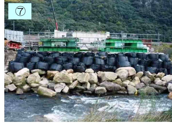
橋をかけるための土台を造ります。
