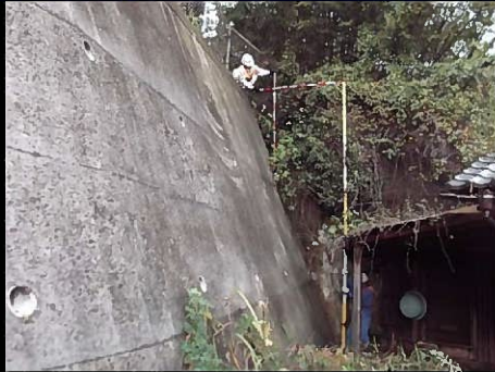
斜面の断面の確認
