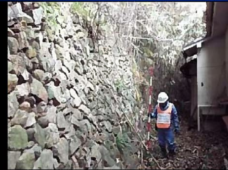
斜面の下端の確認
