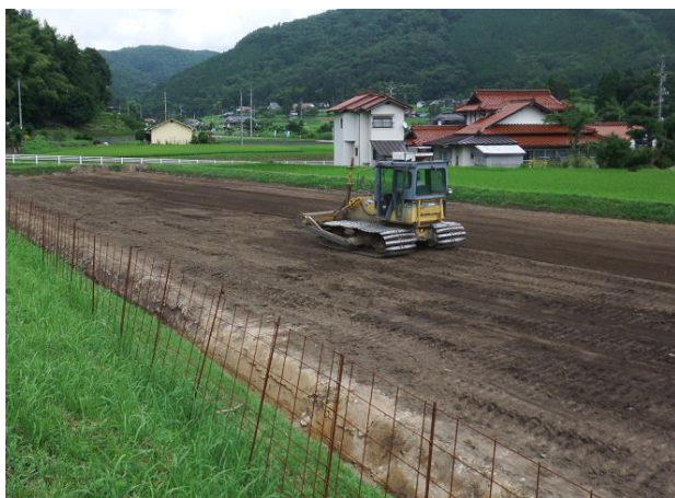
【湿地式ブルドーザによる緩傾斜化作業】
