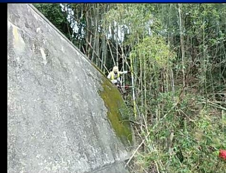
斜面の断面の確認
