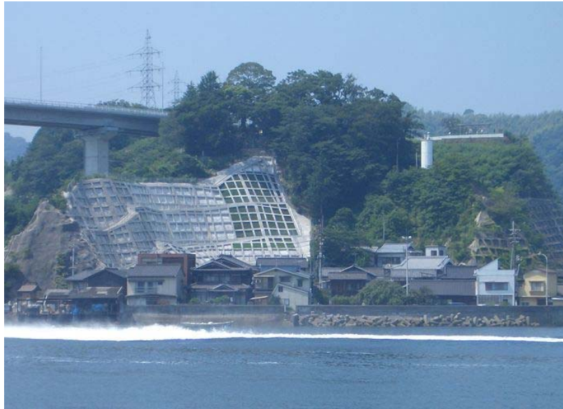
急傾斜地崩壊対策事業 音戸町坪井
