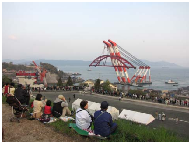
中央径間部の架設工事・見学会 (平成23年4月24日)
