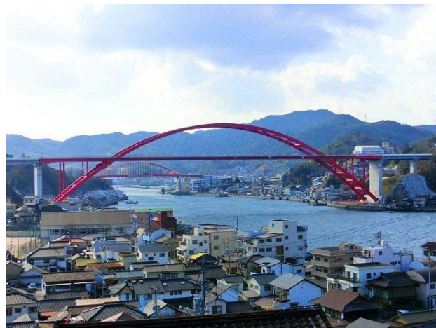
第2音戸大橋 完成写真
