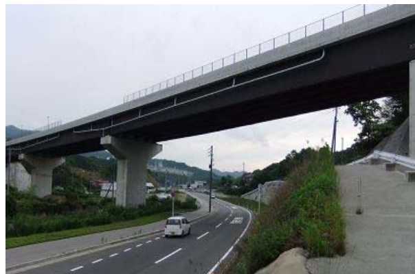
東広島呉自動車道と呉環状線（郷原IC付近） (背後の工場は郷原工業団地)
