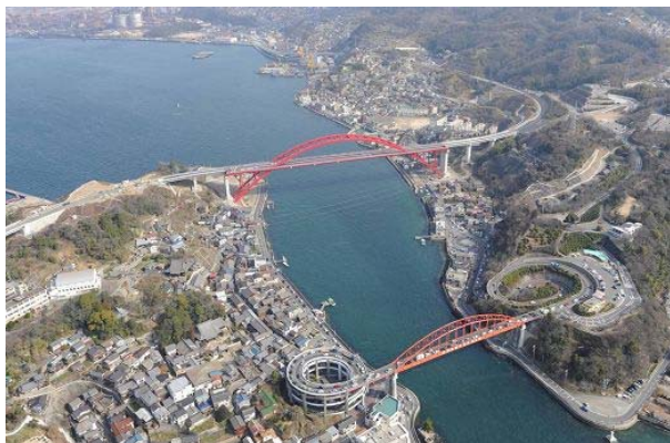
一般国道487号警固屋音戸バイパス第2音戸大橋 (写真中の下の橋梁は音戸大橋)
