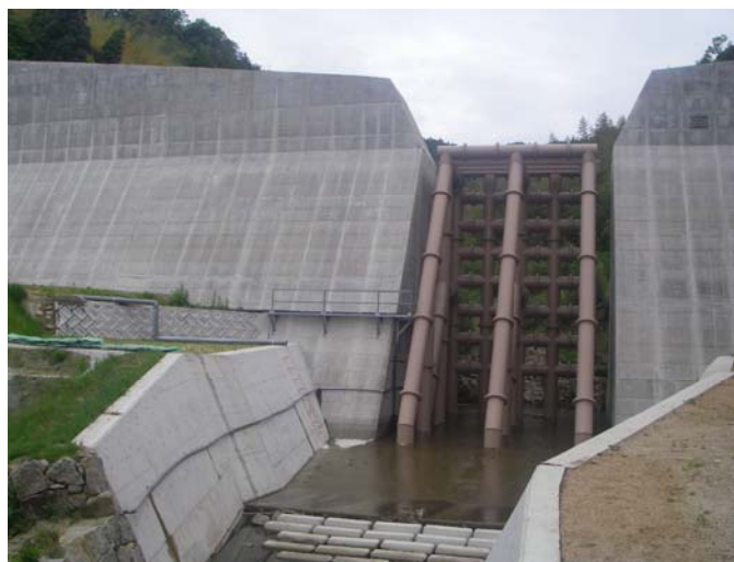
通常砂防事業 砂防指定地内河川 鈍田川
