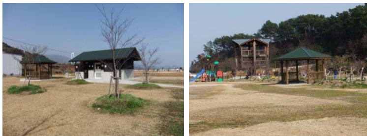
プランに基づいて整備したトイレ，東屋，水飲み場等
