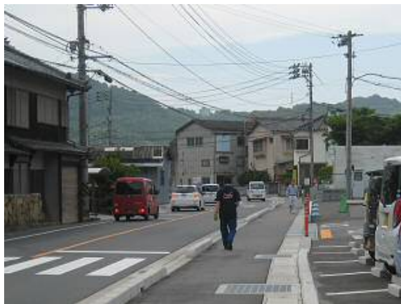
一般国道487号歩道整備 音戸町高須
