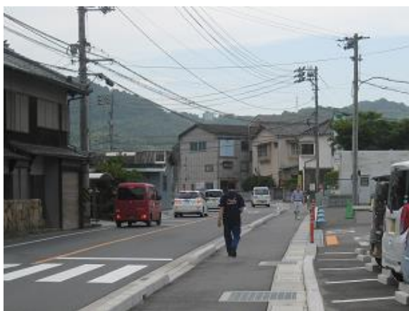
一般国道487号歩道整備 音戸町高須
