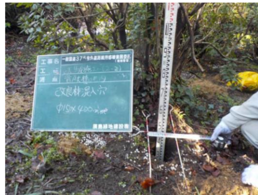
土壌改良状況
