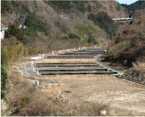
土壤浄化施設全景
