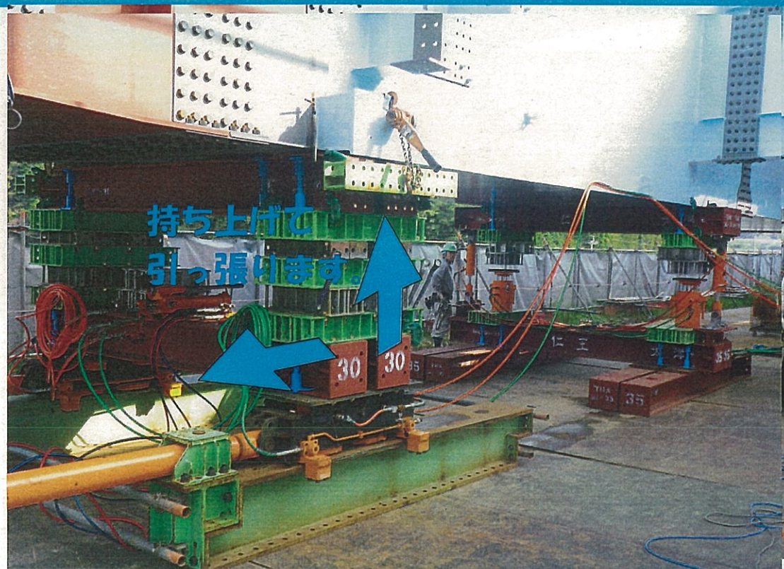
スライドジャッキ+トラニオンジャッキ
