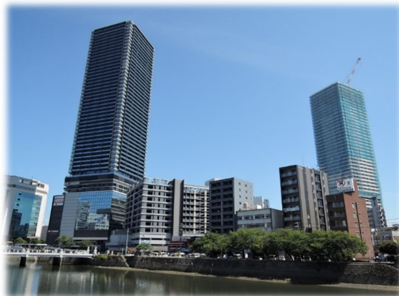
■広島駅南口B・Cブロック市街地再開発事業
