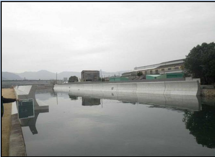
仁保1工区工事完成
