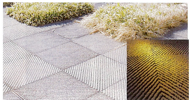
↑歩道部舗装：コンクリートブロック
