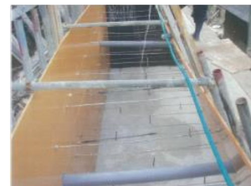
打設前散水湿润状況
