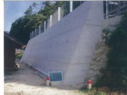
急傾斜地崩壊対策工事
