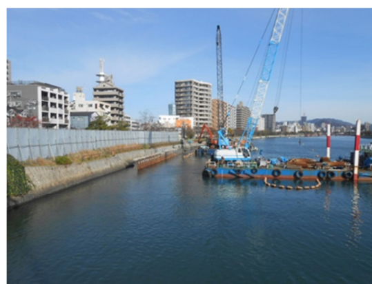
■ 耐震対策施工状況(広島市 京橋川)
