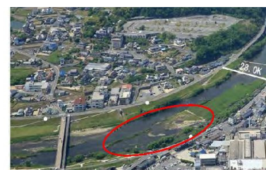
■施工後（平成26年度）
