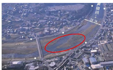
■施工前（平成15年度）
