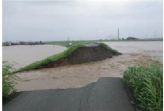
■矢部川の基盤漏水による堤防決壊(H24.7)
