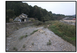
堆積土砂撤去後
