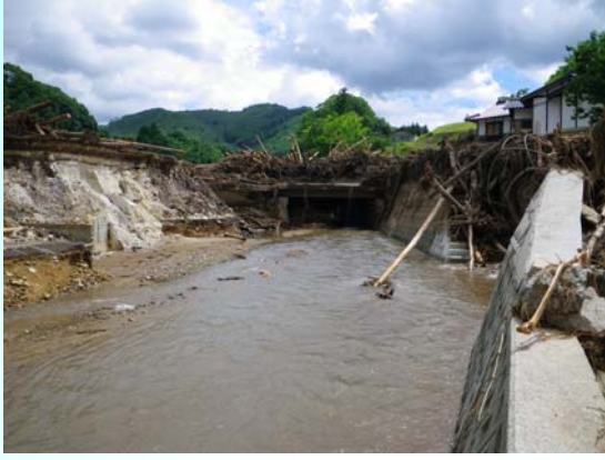
断面障害していた橋の架け替え
