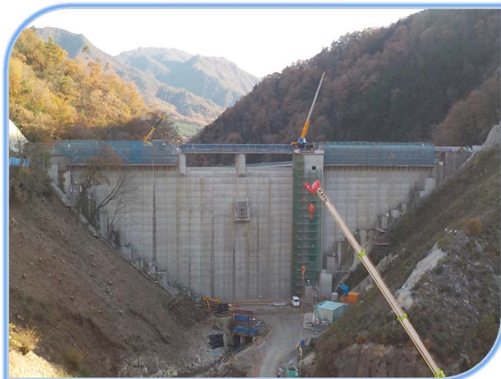
ダム本体上流面
