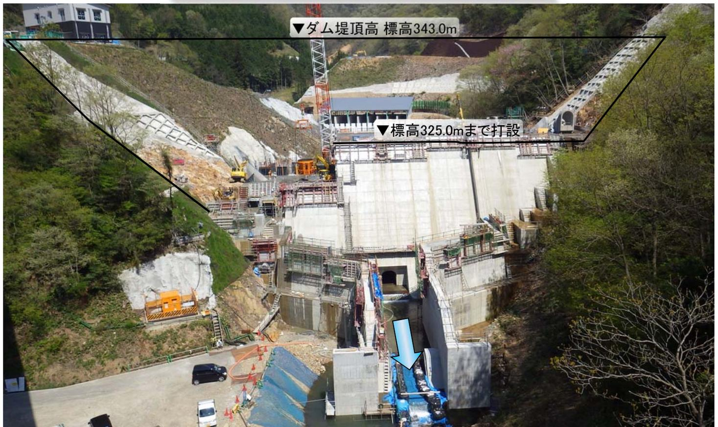
平成27年4月30日時点 **26,000m<sup>3</sup> (61%) 打設**
