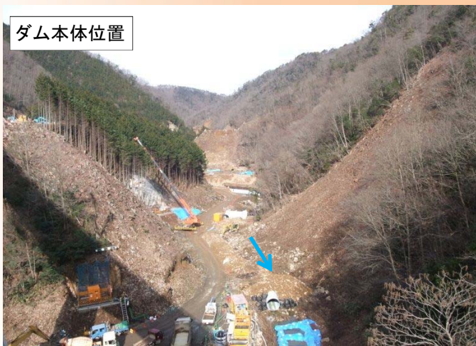
ダム用仮設備建設中
