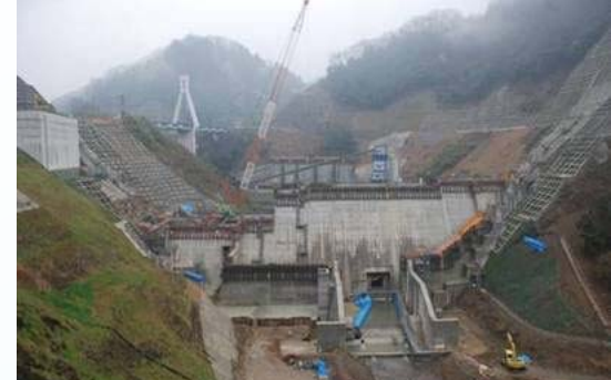
コンクリート打設状況(事例)
