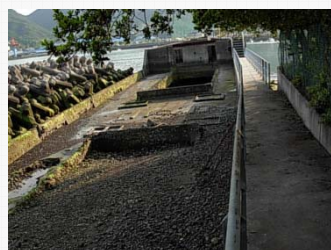
防波堤(陸側のコンクリート船)
