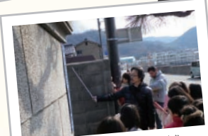
高いブロック塀は地震で倒れる危険があるので近づかない。
